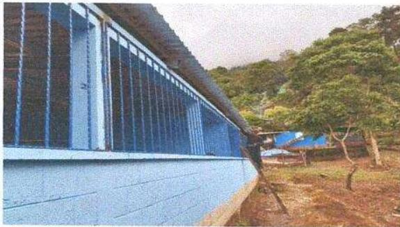
Foto 3 Sustitución de balcones de metal
