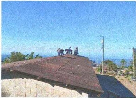
Foto 1: Sustitución de lamina, por lámina troquelada aluzinc calibre 26, sustitución de elementos de fijación
